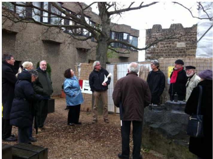
Besichtigung der Sanierungsarbeiten der Godesburg mit Interessierten. Für die Sanierung hat das Land 350.000 Euro bereitgestellt.
